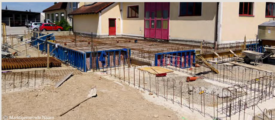
Aktueller Stand (per 17.06.2024) der Feuerwehruiserweiterung. Fertigstellung der Streifenfundamente, Bodenplatten betonieren, ...
