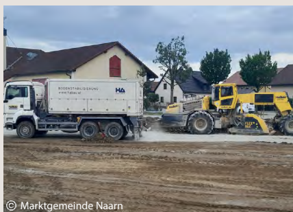
Maßnahmen zur Bodenstabilisierung
